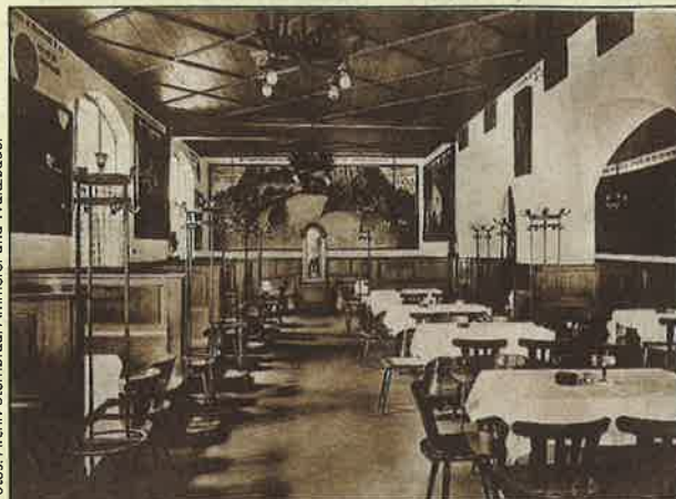
Der Garten- bzw. Bürgersaal in den 30er-Jahren
