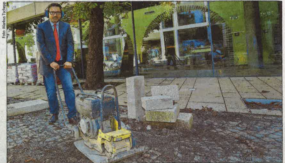
Lässt die Baumaschine über die letzten noch lockeren Pflastersteine rattern: Sternbräu-Wirt Harald Kratzer ist froh, wenn es am 1. Oktober wieder losgeht. In der Glasfassade spiegeln sich die Arkaden.
