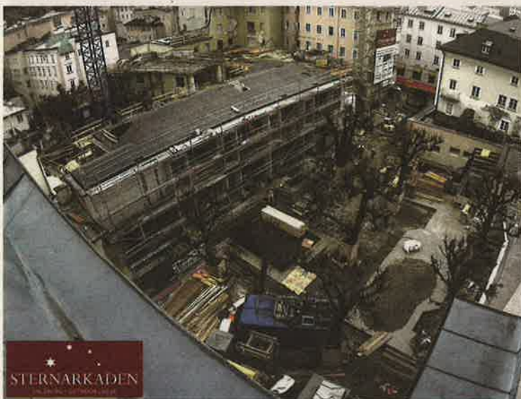
Die Sternarkaden sind derzeit noch eine Großbaustelle, wie auf den Bildern der Webcam zu erkennen ist. Zu sehen unter: www.sternarkaden.at
